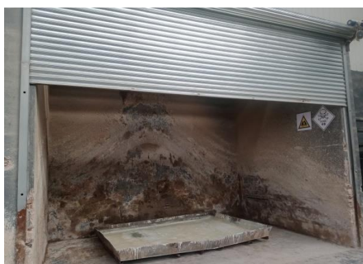
二次滤渣落料间
