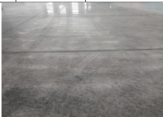
生产车间地面（围堰外）
