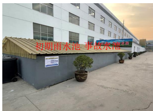
初期雨水池、事故水池（中间隔断）
