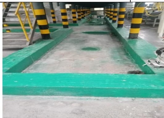
生产车间地面（围堰内）
